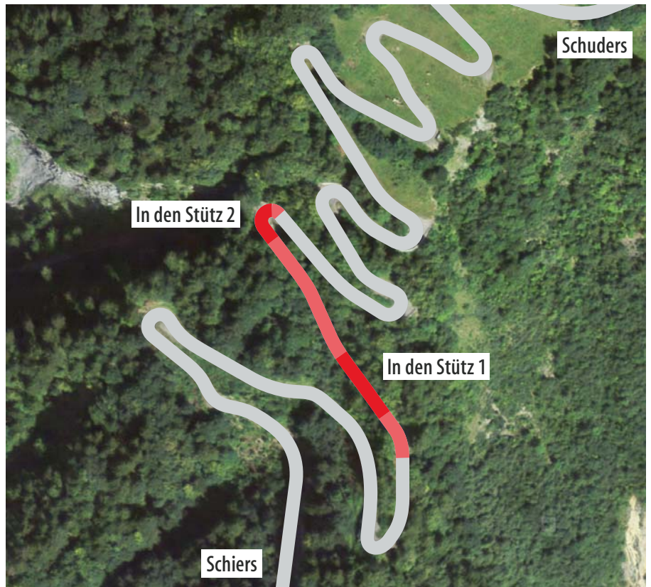
Der geotechnisch schwierige Hang mit den Strassenkehren unterhalb Schuders.
