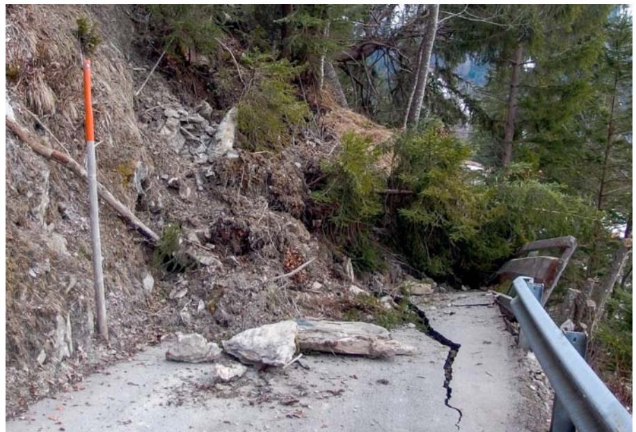
Das zerstörte Strassentrassée infolge des Erdbebens im Februar 2014.
